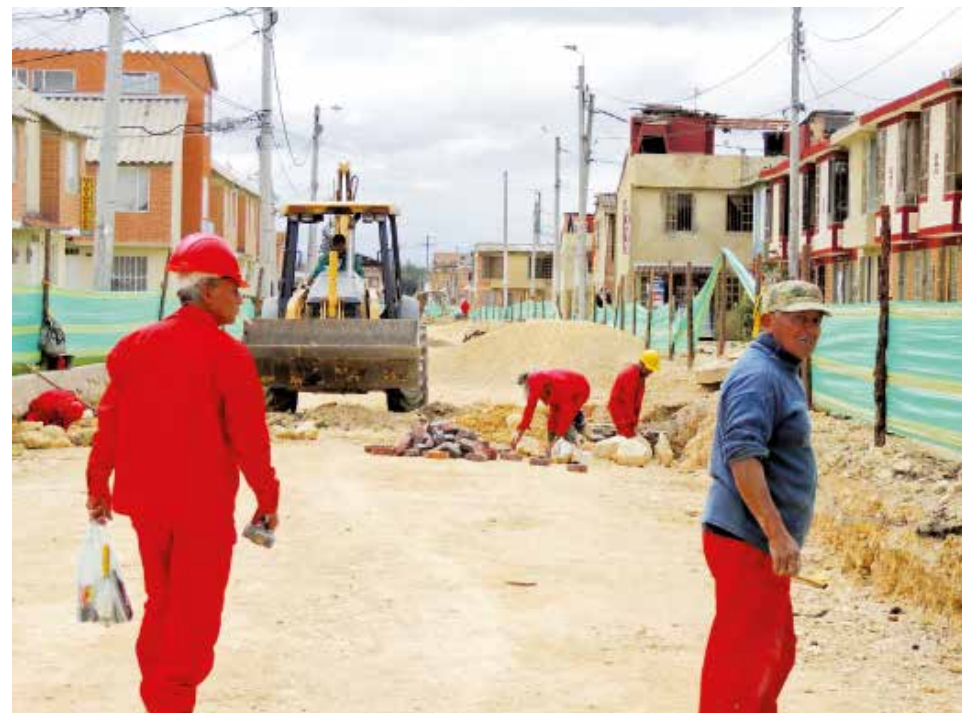
Construcción calle 21 entre carreras segunda y quinta.
