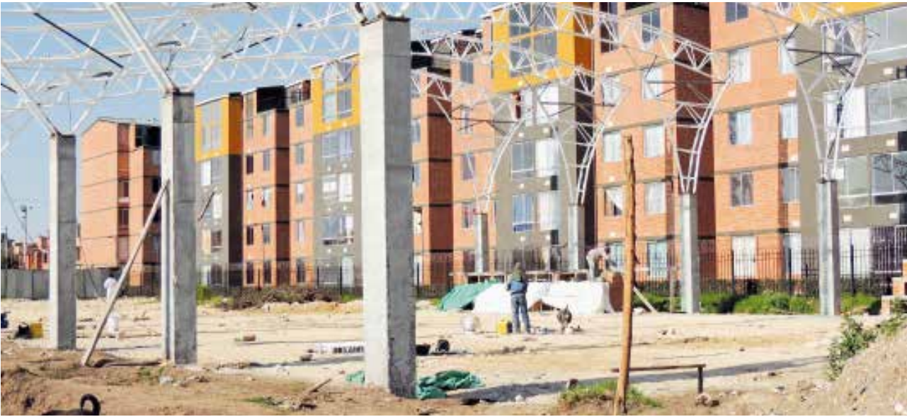
Construcción del polideportivo barrio El Hato segundo sector. (calle 21 carrera segunda).
