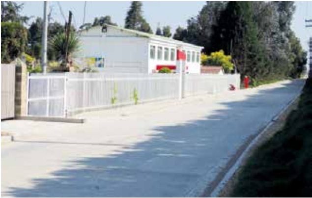
Pavimentación de 200 metros frente al colegio San Ramón.
