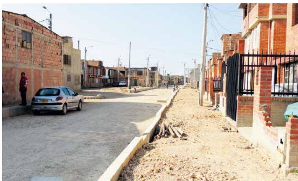
En desarrollo y construcción de la avenida calle 21, entre carreras segunda y quinta.
