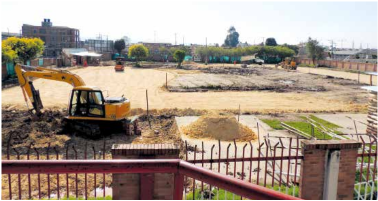
Construcción de la nueva sede de la Miguel Antonio Caro en Funza.
