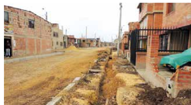
Construcción Avenida calle 21 entre carreras segunda y quinta.
