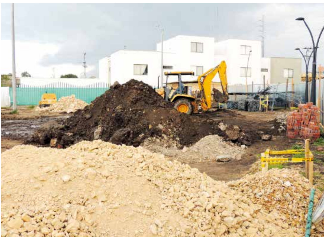
Construcción del Palacio de Justicia de Funza.
